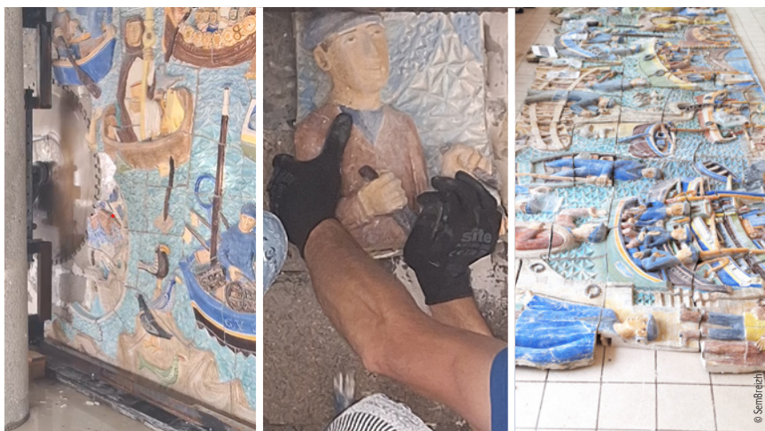
La fresque Armor a été minutieusement déposée. Elle sera de nouveau visible dans quelques mois dans le bâtiment historique.
